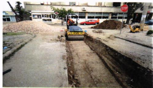
Останалата част от изкопа до нивото на конструкцията за пътната част, ще се засипе със скална маса - фракция.
